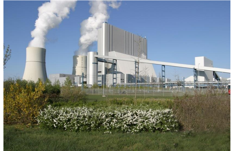
Power plant Schwarze Pumpe. Source: Vattenfall
